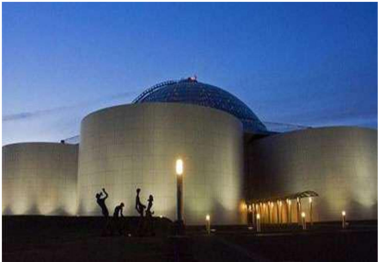
Ресторан Perlan (Рейк'явік) розташований на даху великих баків гарячого водопостачання
