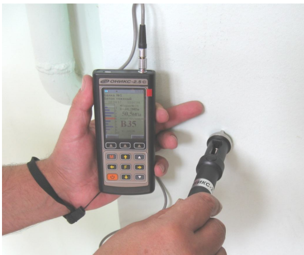
Рисунок 3.10 – Робота по визначенню міцності бетону електронним приладом ударної дії типу «Онiкс-2,5»
