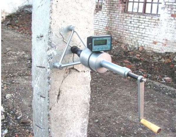
Рисунок 3.2 – Випробування міцності бетону методом відриву за допомогою приладу ПОС-50МГ4
