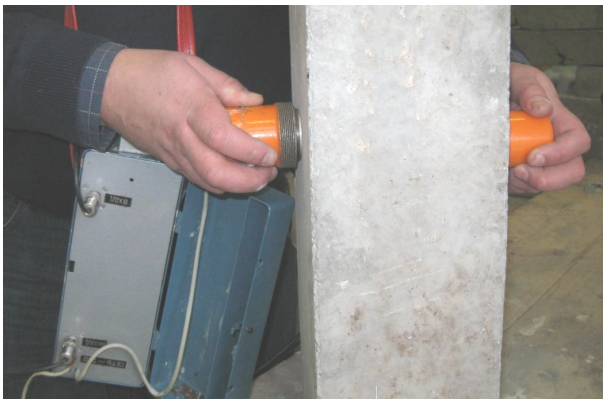
Рисунок 3.15 – Робота з визначення міцності бетону переносним ультразвуковим приладом
