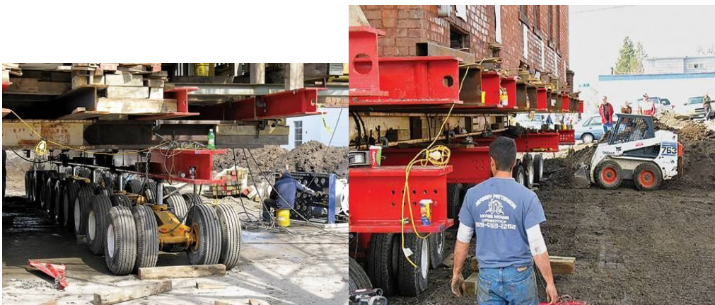
Рисунок 4.26 – Сучасні технології переміщення будівель
