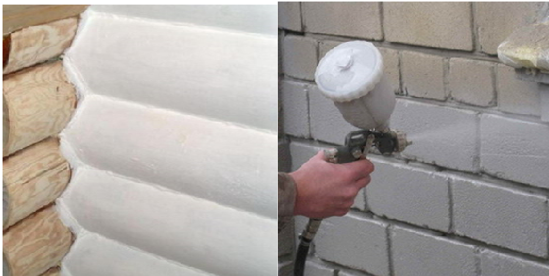
Рисунок 1.14 – Нанесення рідкої теплоізоляції
