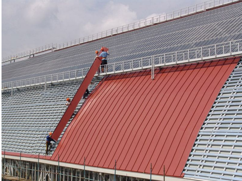
Рисунок 4.8 – Улаштування сталеві фальцевої покрівлі
