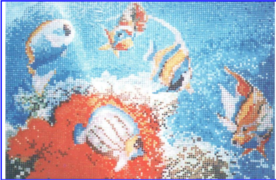
Рис. 5.7. Облицювання стін мозаїчними скляними плитками.
