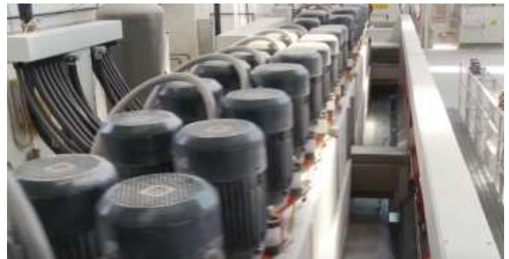
Рис. 4.121 Загальний вигляд балок поперечного руху
