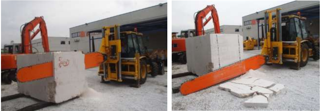
Рис. 4.103 Розпилювання блоку баровою пилою.
