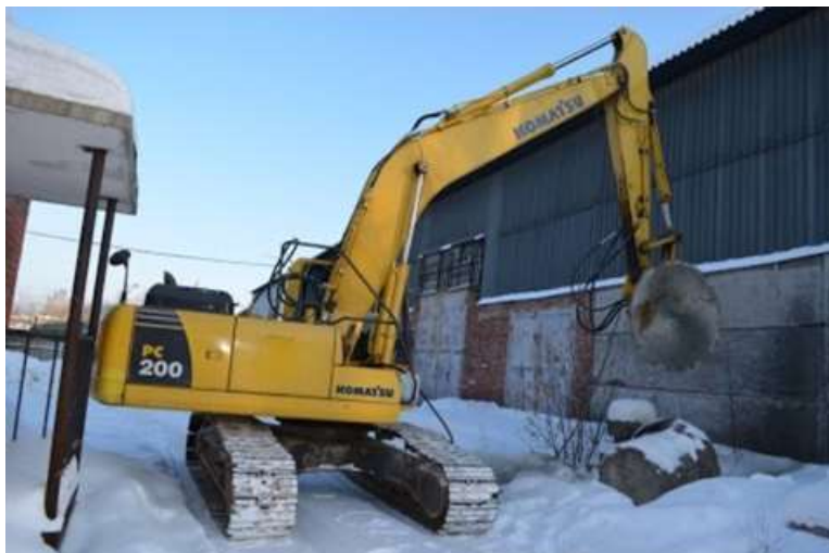
Рис. 3.9 Каменерізна пила Pilemaster RS15 на базі екскаватора
