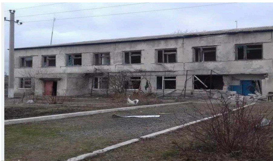
Рисунок 1.8 — Зруйнована очисна споруда в с. Верхня Криниця, Запорізька область
