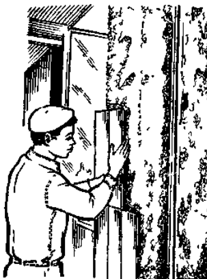
Облицювання стін облицювальними плитами товщиною 10 мм
