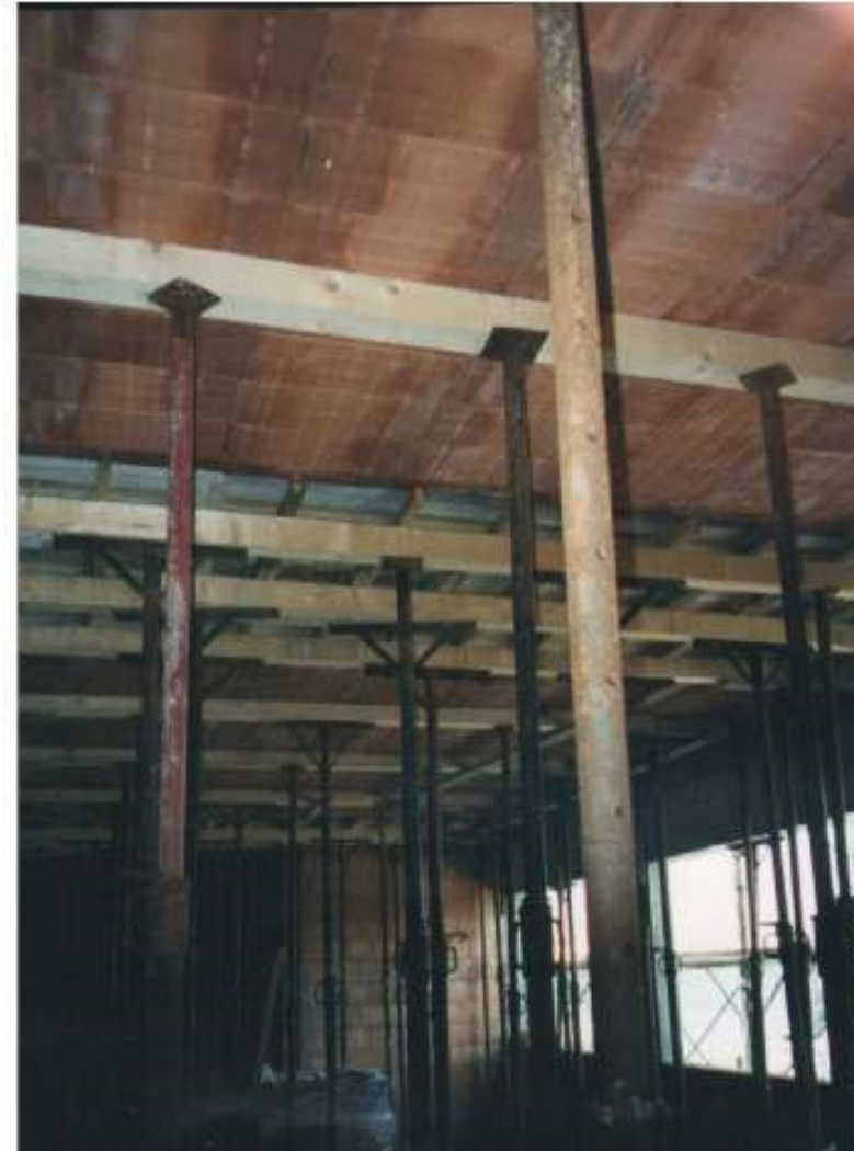
Загальний вигляд керамічної опалубки: а – балок; б – перекриття із керамічних каменів у процесі бетонування
