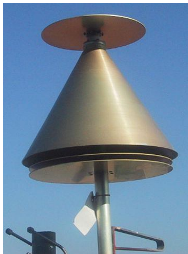
Приклади дисконусних антен
