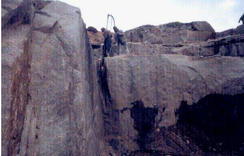
Рис. 74. Процес проходки щілини за допомогою терморізака "Тайфун"
