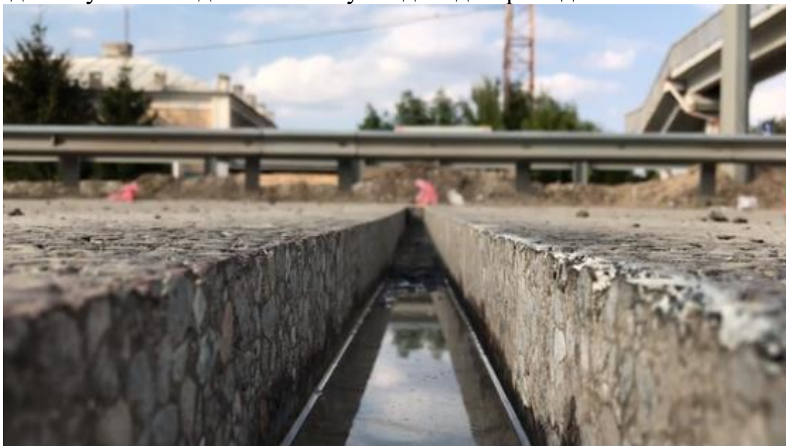
Рис. 7.7 Один зі швів, які вирізали для монтажу датчиків
