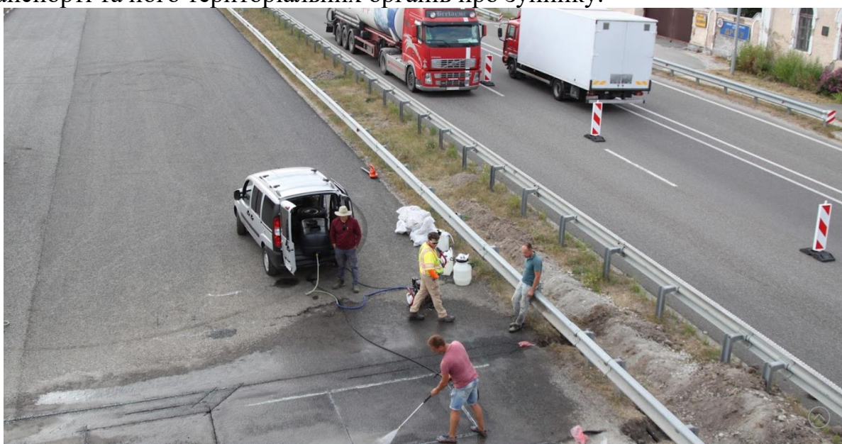
Рис. 7.6 Встановлення датчиків зважування системи Зважування в русі
