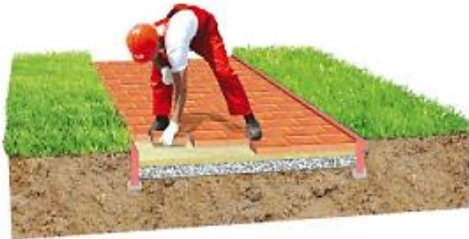
Рис. 6.6. Приклад процесу укладання бруківки від краю до центру
