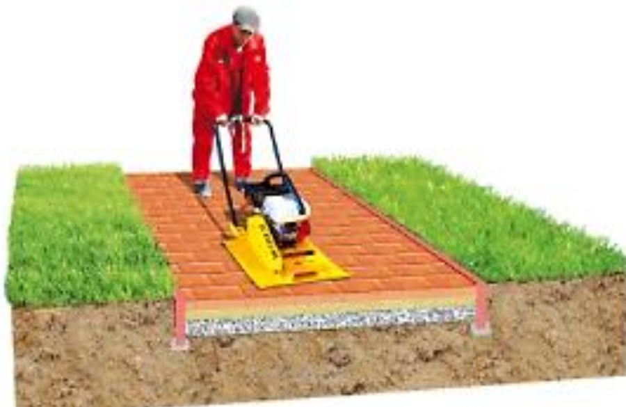
Рис. 6.7. Процес ущільнення поверхні
