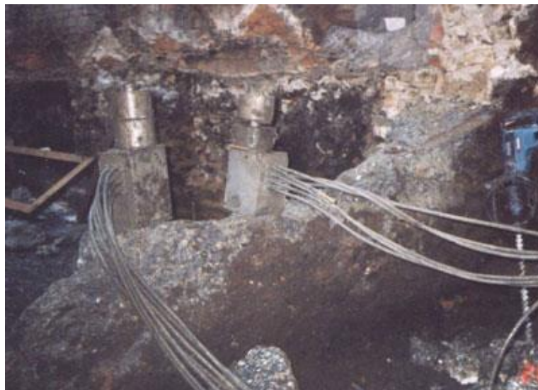
Рис. 9. Підготовка фундаменту до розколювання
