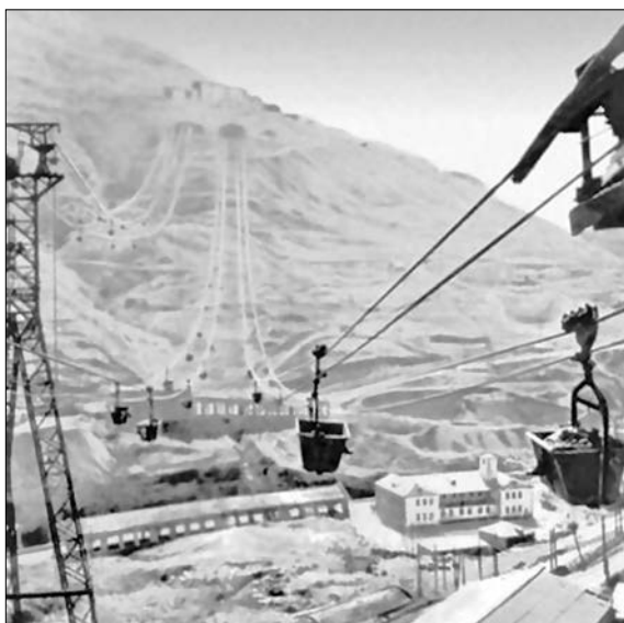
Рис. 5.26. Підвісна канатна дорога для транспортування руди в гірських умовах
