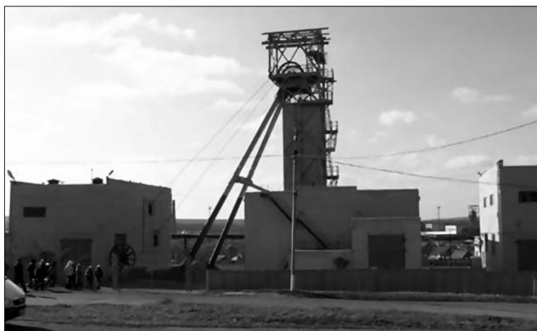
Рис. 5.33. Надшахтний копер
