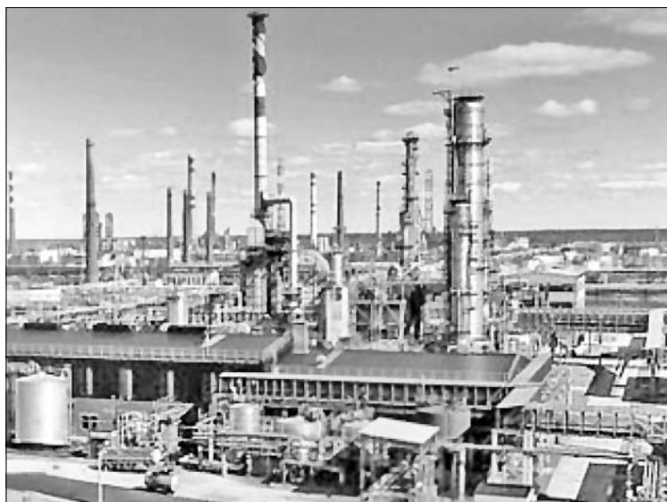
Рис. 6.14. Загальний вигляд нафтопереробного заводу
