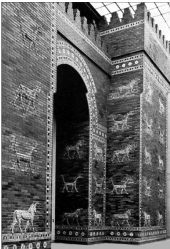
Рис. 3.20. Ворота храму богині Іштар у Вавилоні, споруджені близько 570 р. до н. е. з глазурованої цегли, скріпленої асфальтом
