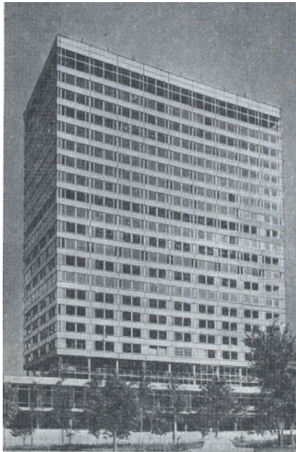
Рис.18.4. Приклад сучасної будівлі з полегшеною стіною. Будинок проектних організацій у Москві
