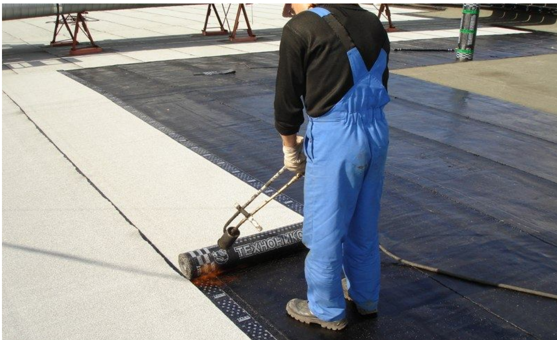
Рисунок 6.12 – Влаштування рубероїдної покрівлі
