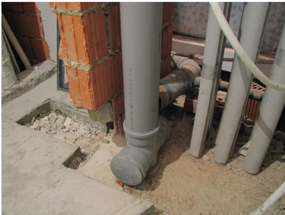
Рисунок 7.3 – Встановлення ревізії на каналізаційному стояку
