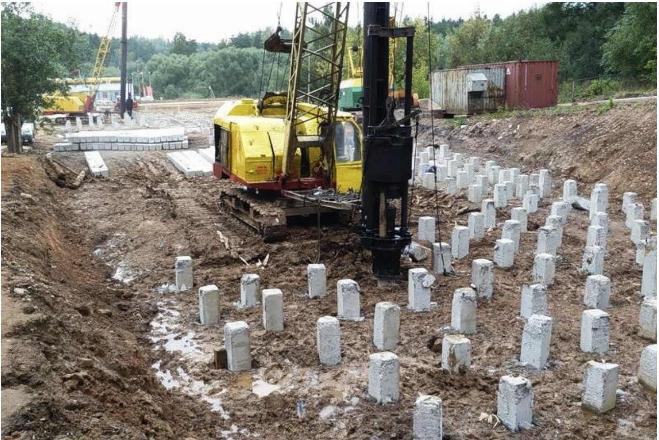
Рисунок 6.3 – Пальове поле із залізобетонних паль
