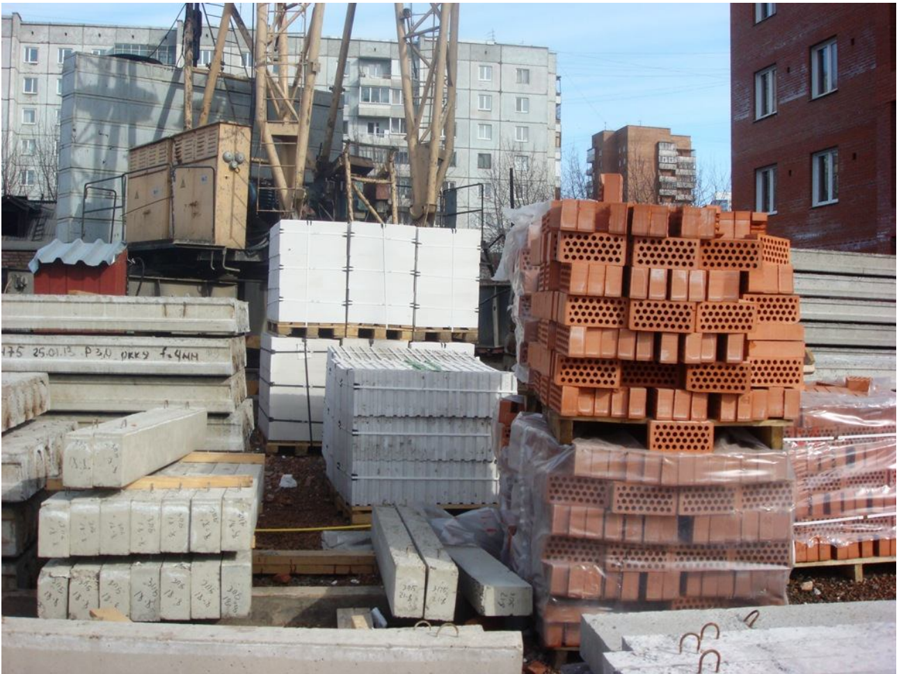
Рисунок 5.14 – Складування будівельних конструкцій та матеріалів на будівельному майданчику
