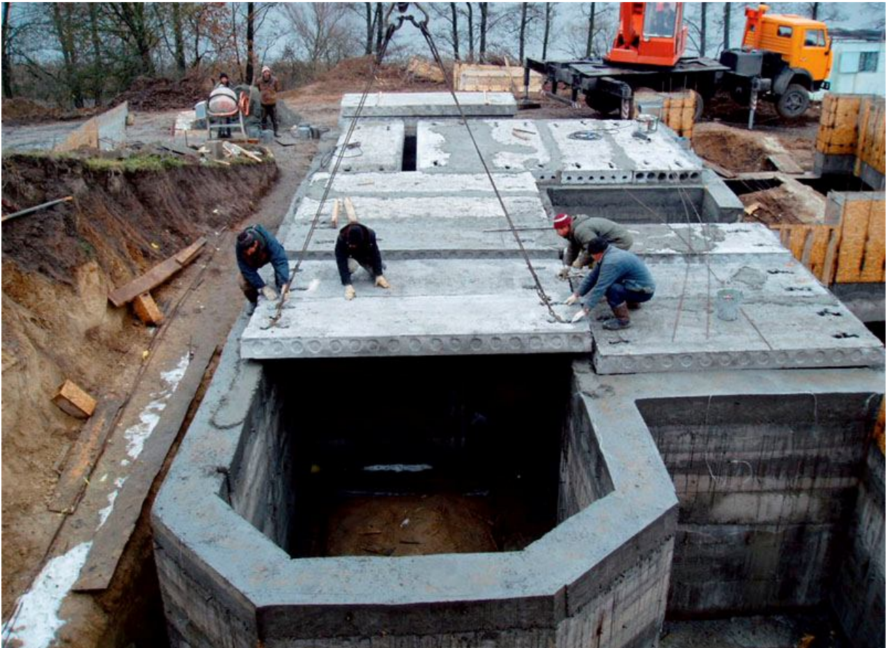
Рисунок 6.8 – Багатопустотні плити перекриттів
