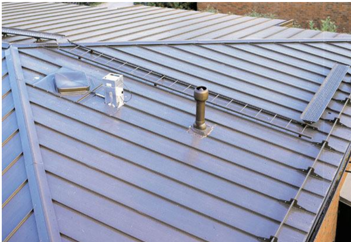
Рисунок 6.11 – Покрівля з оцинкованої сталі
