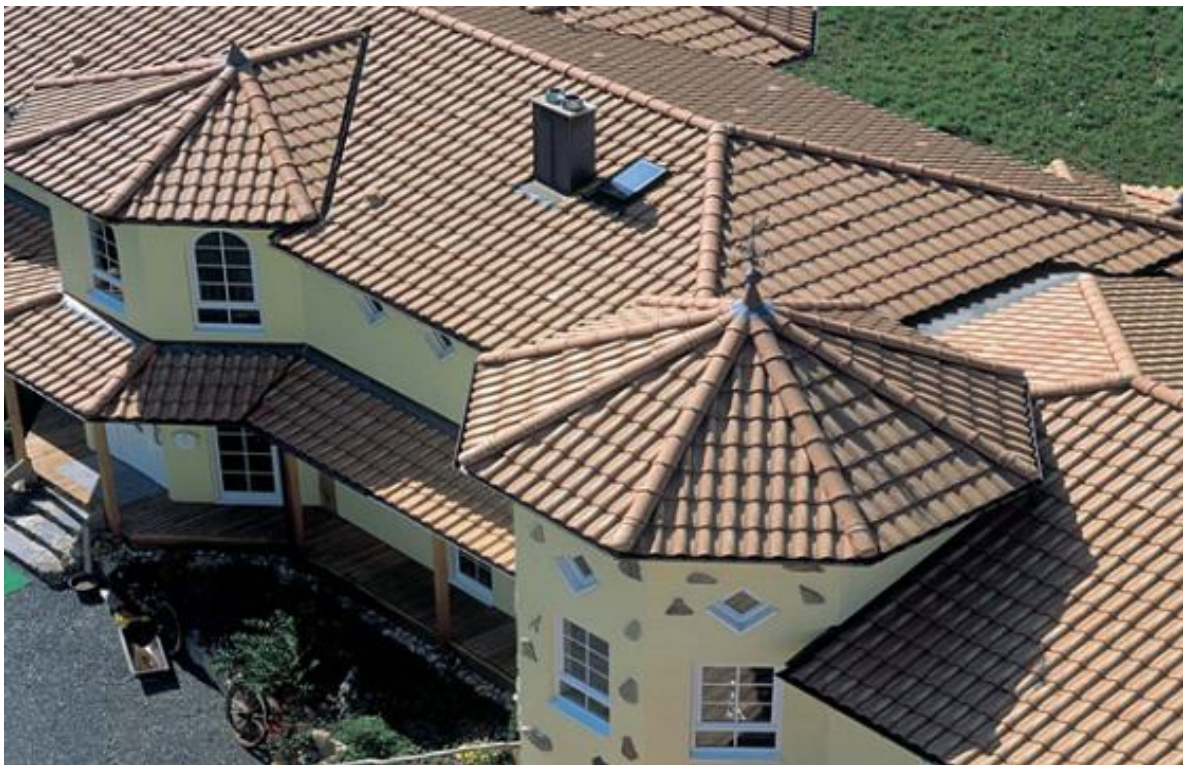
Рисунок 6.13 – Покрівля з глиняної черепиці
