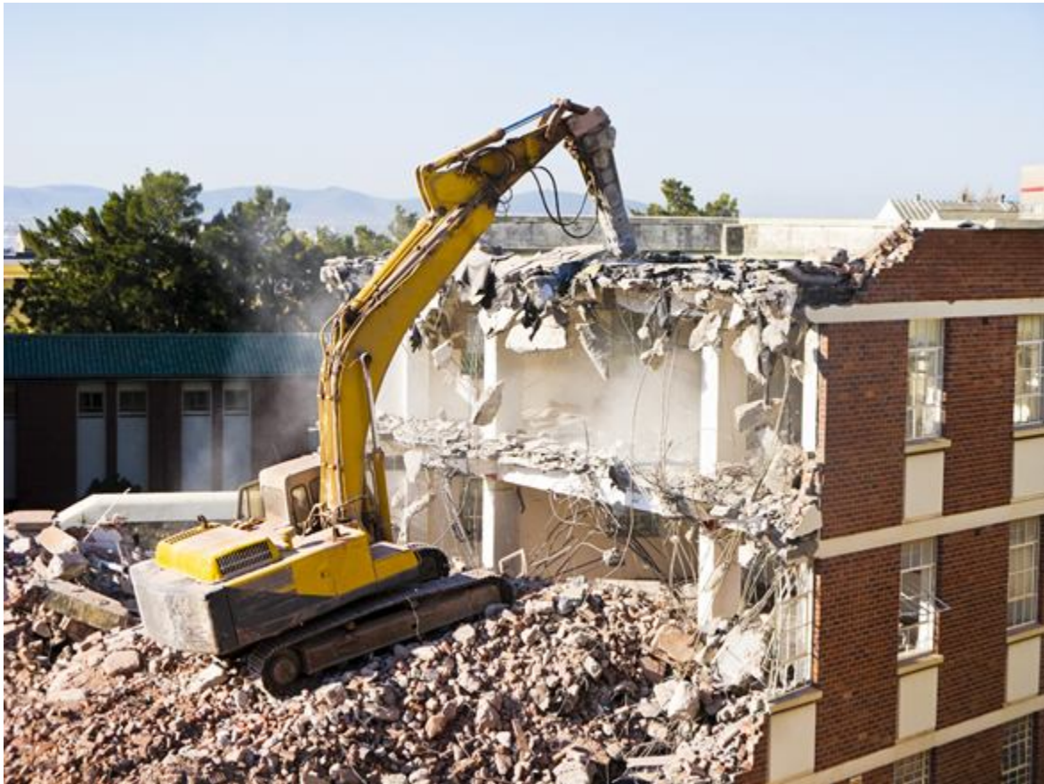
Рисунок 4.2 – Розбирання цегляної будівлі за допомогою екскаватора, обладнаного допоміжними ударними пристроями
