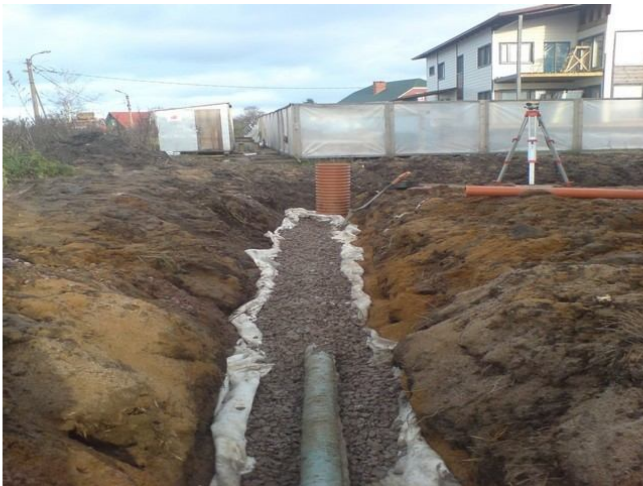
Рисунок 4.3 – Улаштування дренажу будівельного майданчика
