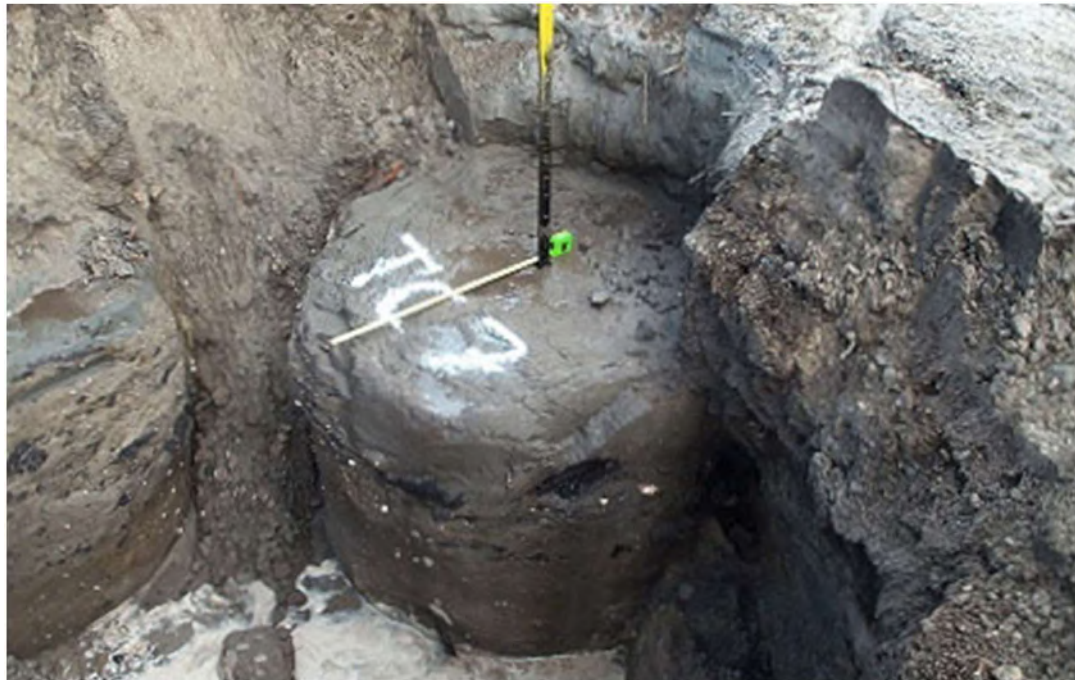
Готова ґрунтоцементні паля
