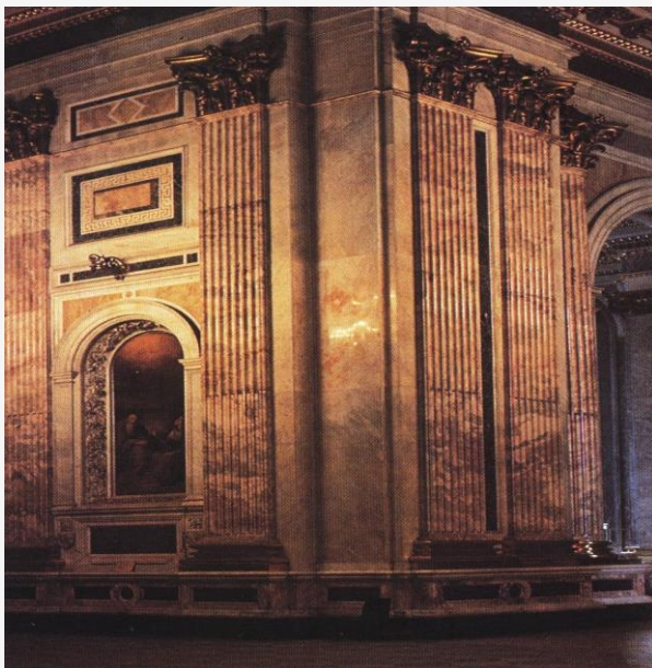
Исаакієвський собор. Фрагмент облицювання стіни. Вставка – соломєньська брекчія в рамці білогірського мармуру
