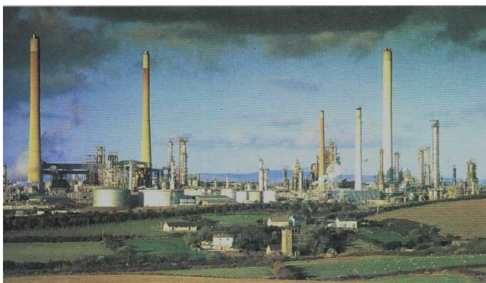
Рис. 6.2. Загальний вигляд нафтопереробного комплексу
