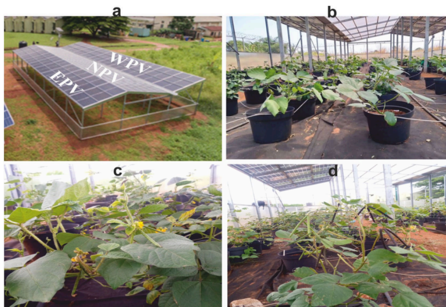
Рисунок 1 – Агровольтаїчна установка та етапи розвитку рослин під сонячними панелями.
