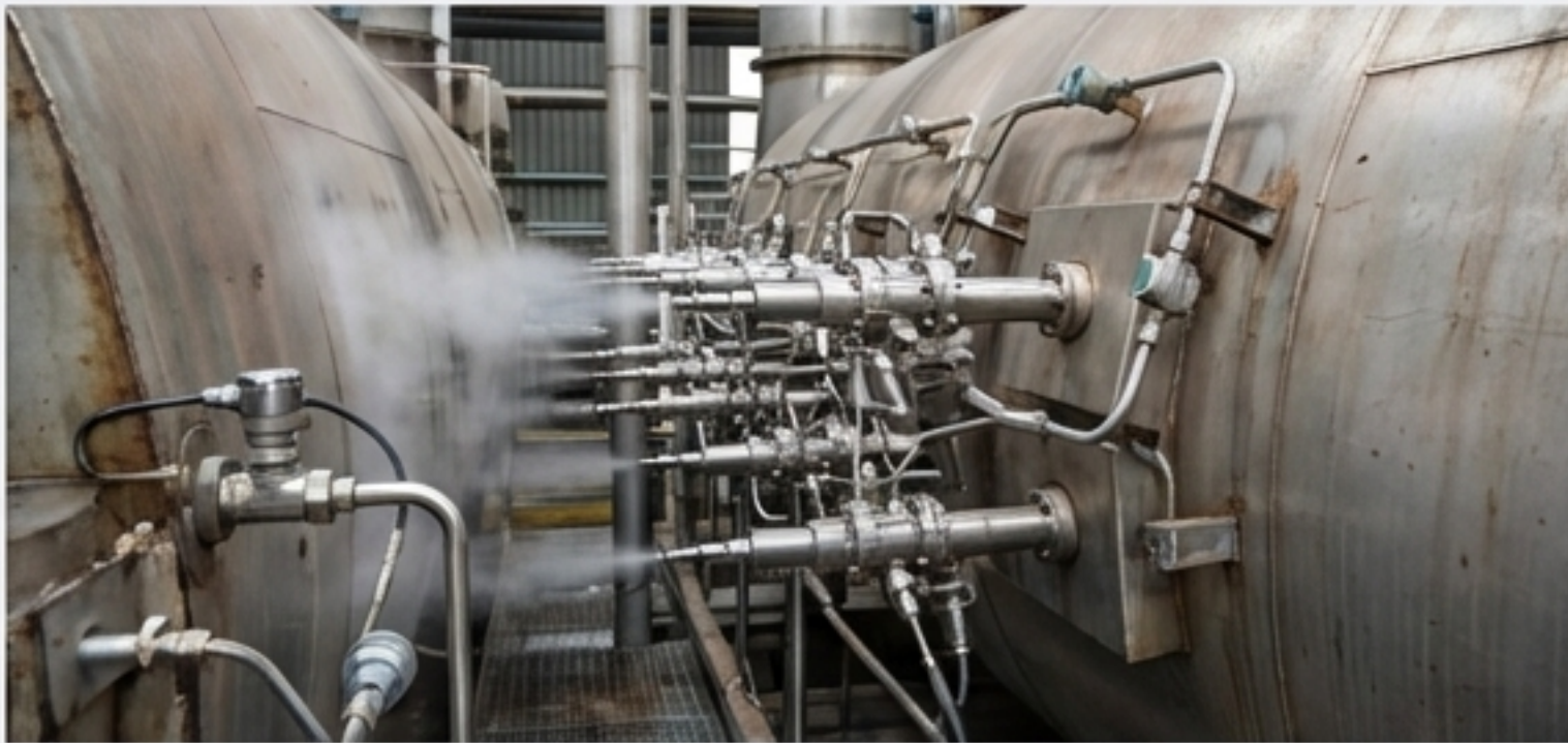
СНкВ (SNCR): Селективне Некаталітичне Відновлення
