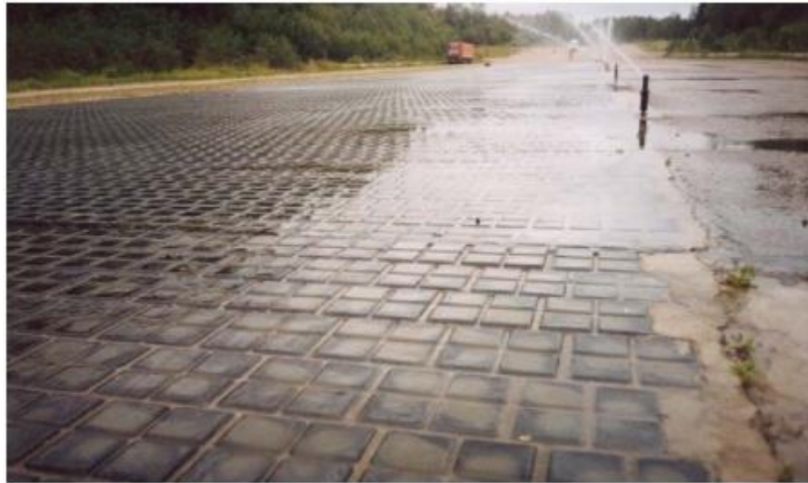
Рис. 5.5. - Штучне покриття з низьким коефіцієнтом зчеплення - зволожена базальтова плитка
