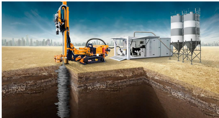
Рис.7.2. Приклад укріплення основи шляхом цементації
