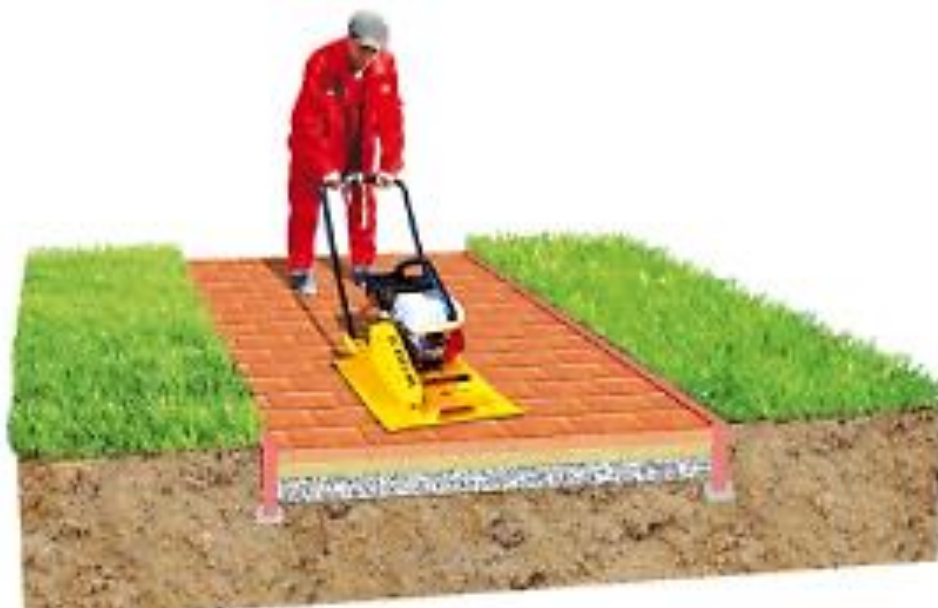
Рис. 7.7. Процес ущільнення поверхні
