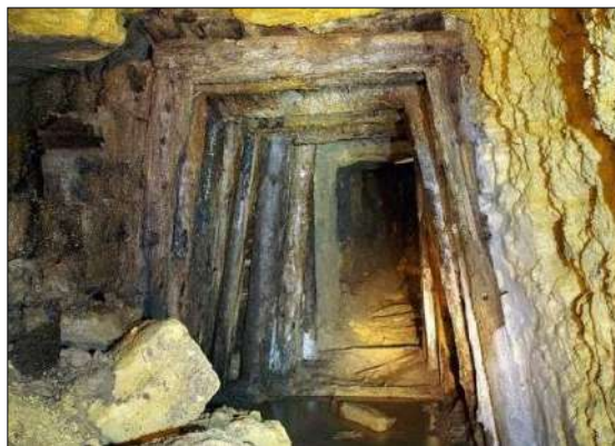
Штольня з кріпленням
