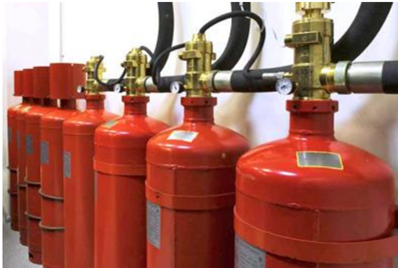
Газова система автоматичного пожежогасіння
