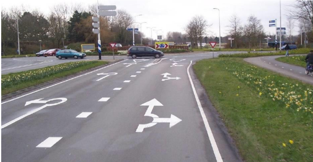
Рисунок 34 - Кільцеве пересічення на одному рівні (джерело: [19])
