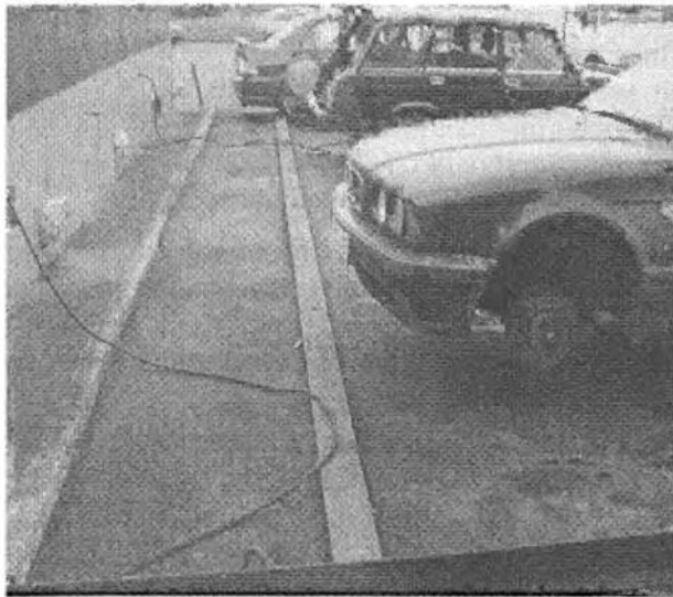
Рис. 9.18 в. Подвод сжатого воздуха и освещение рабочих мест снятия и установки колес
