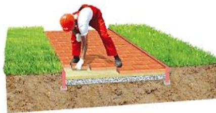
Рис.25. Приклад процесу укладання бруківки від краю до центру
